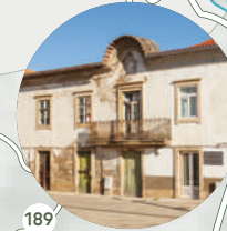
189 Solar dos Condes de Vinhais Mirandela El eje formado por la puerta y el mirador se ve acentuado por el escudo de los condes de Vinhais y culmina con la imagen en piedra que representa al apóstol Santiago a caballo, blandiendo una lanza, vestido de combatiente.
