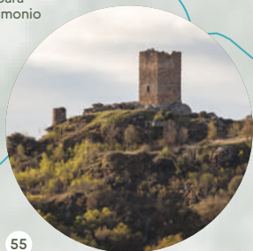
55 Casillo de Penas Roias Penas Roias
