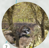
7 Ponte Gótica Pinelo Puente de dos tramos sobre el río Maças, entre Pinelo y Argozelo. Raro ejemplar, con signos de estilo gótico y acera. Habría sido construida a finales del siglo XIV, principios del XV.
