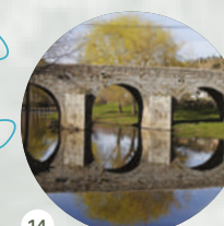
14 Ponte de São Joanico Vale de Frades
