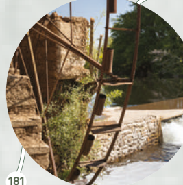
181 Açude de Abambres Abambres
