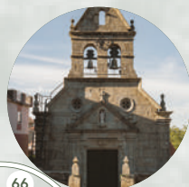
Igreja de Santa Comba Santa Comba de Rossas
