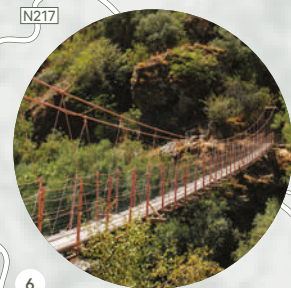
6 Ponte dos Mineiros Argozelo
