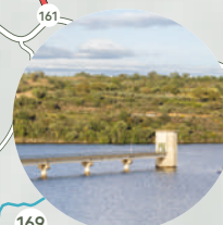
169 Azibo Dam Vale da Porca
