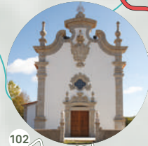
102 Sanctuary of Nossa Senhora dos Remédios Tuizelo
