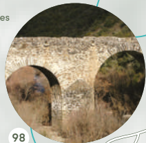
98 Gestosa Bridge Gestosa
