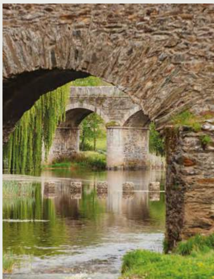
A Ponte de Gimonde ou Ponte Velha, faz a travessia a cerca de oito quilómetros de Bragança, cem metros a montante da ponte de finais de século XIX.
