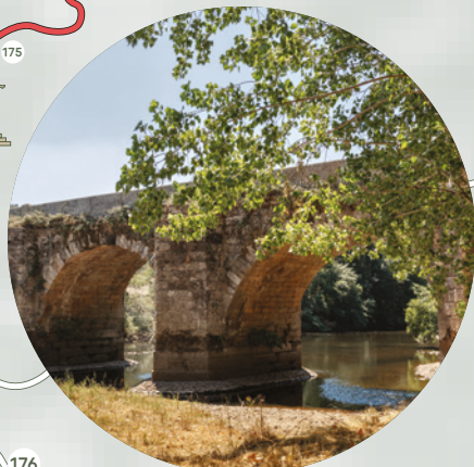
Ponte sobre o rio Tuela Torre de Dona Chama
