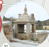
31 Fonte dos Canos Miranda do Douro
