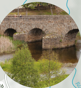
116 Ponte de Gimonde Gimonde
