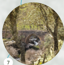
7 Ponte Gótica Pinelo
